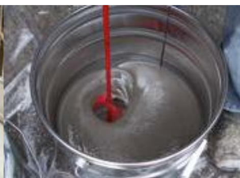
6. Misture os componentes A e B
