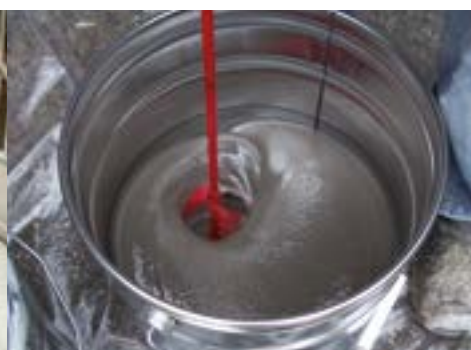
6. Misture os componentes A e B
